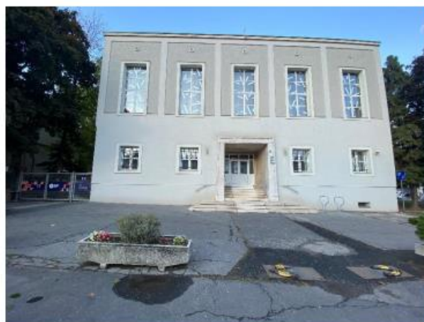
Bild 2: Eingang zum Gebäude 'E'
